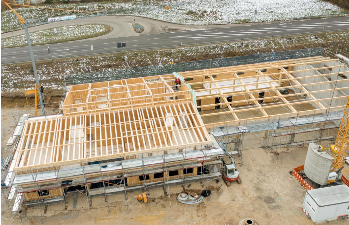
Luftbild Neubau Blaulichtzentrum Westhausen mit Feuerwehrgerätehaus, DRK-Räumen und Polizeiposten
