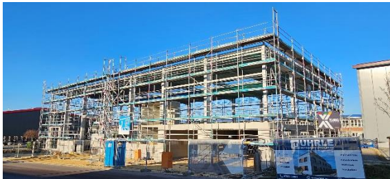
Neubau Firma BrandSelect (Großhandel Haus- und Gartengeräte)
